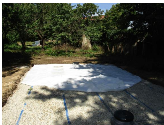
Filtre à sable non drainé
